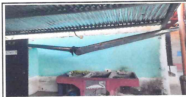
Foto 5: Sustitución de bajada pluvial de tubo PVC3" por metal.
