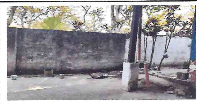
Foto 12: Aplicación de pintura en muro perimetral interiores y exteriores
