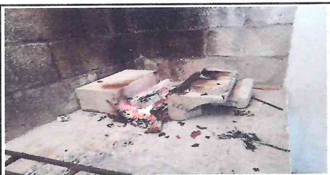
Foto 9: Implementación de Hornillas de ladrillo con parrilla de hierro corrugado
