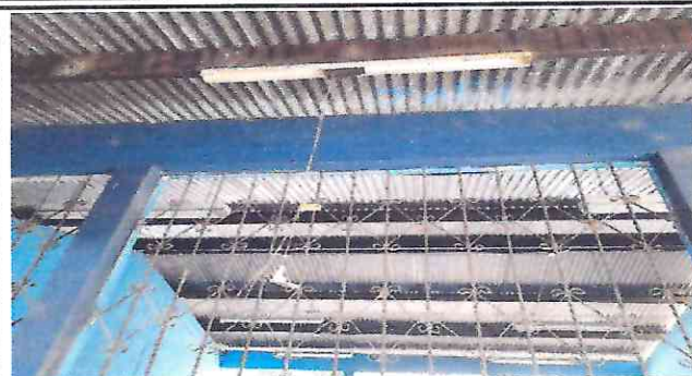
Foto 8: Sustitución de lámparas fluorescentes por focos ahorradores de energía
