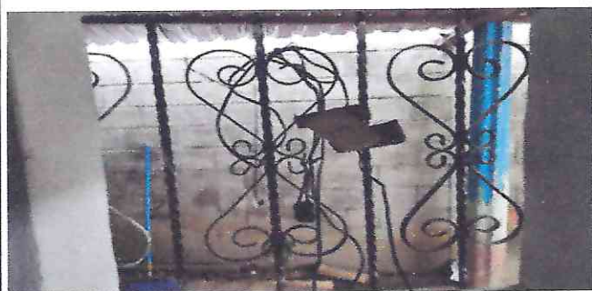
Foto 7: Reparación de Cableado eléctrico en salones, cocina y techo del patio
