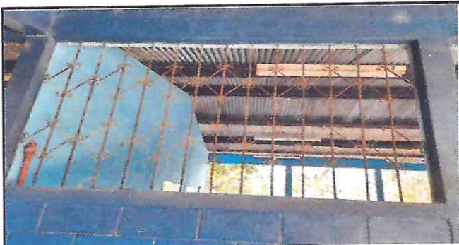
Foto 3: Mantenimiento a balcones de metal, lijado y aplicación de pintura.
