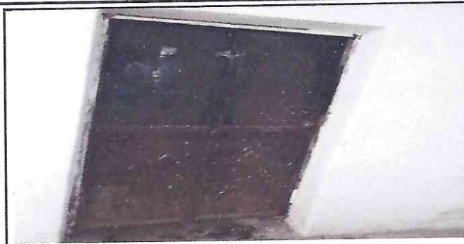
Foto 1: Mantenimiento de puertas de metal, lijado, aplicación de pintura
