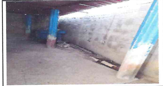
Foto 4: Sustitución de cemento líquido en cocina.
