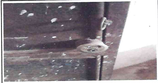
Foto 2: Sustitución de chapas de puertas de metal.
