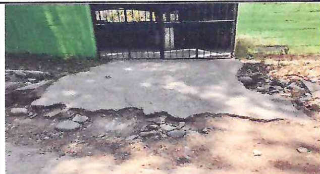
Foto 10: Reparación de Rampa de acceso al establecimiento educativo.
